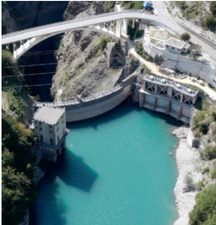
Barrage du Sautet
