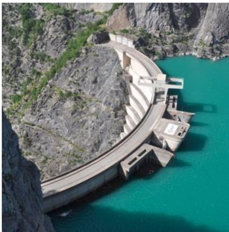
Barrage de Monteynard-Avignonet
