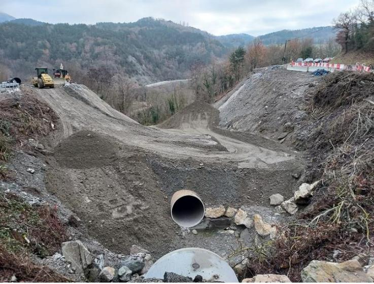
Un chantier de grande ampleur et une buse géante de 2 mètres de diamètre.
