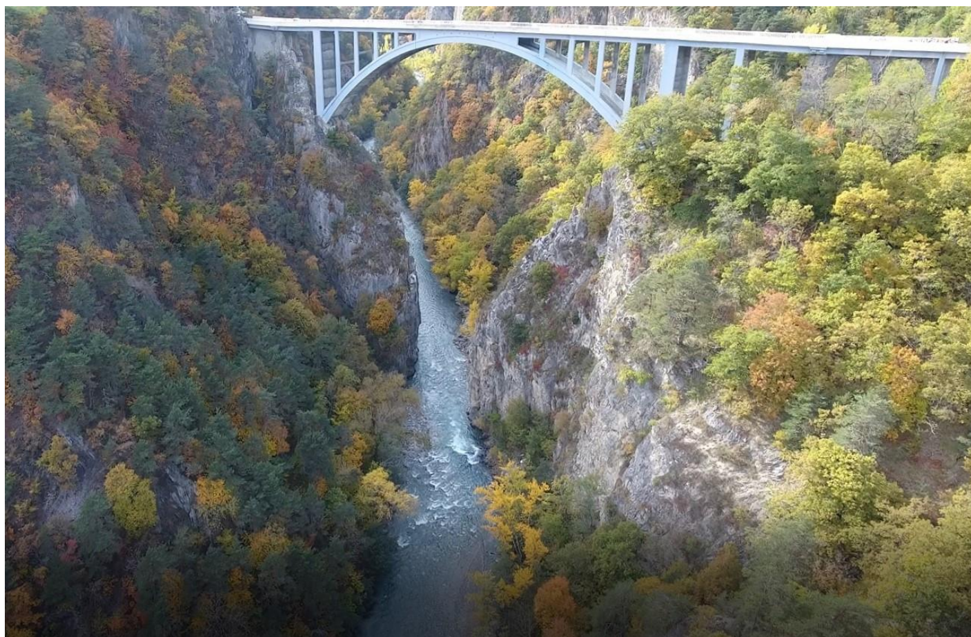
Le pont suspendu édifié en 1861, inadapté à la circulation des poids lourds, a été remplacé par un pont en béton mis en service en 1941.
